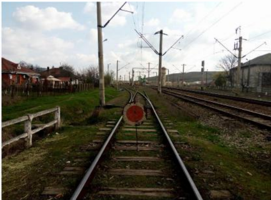
Foto nr.1 – Disc roșu montat la vârful macazului nr.10 (acces blocat la fasciculul de linii 1 – 3)
