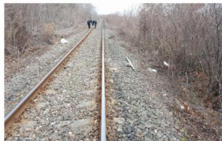
Imaginea 2 - zona unde s-a produs deraierea vagonului remorcă LVS 538
