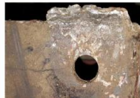
Imaginea 8 - pe suportul de la rezervor, sudura veche, oxidată, prezenta majoritar ruptură veche
